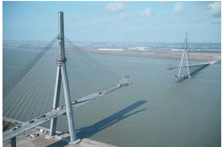
Construction du pont de NORMANDIE
